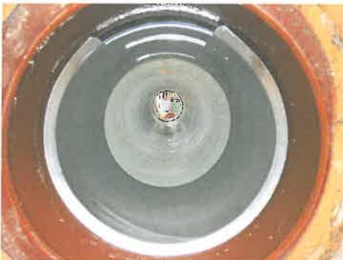
Bild 2: Circum-LEM im Steinzeugrohr; dichtet den Ringspalt zwischen Liner und Rohr ab
