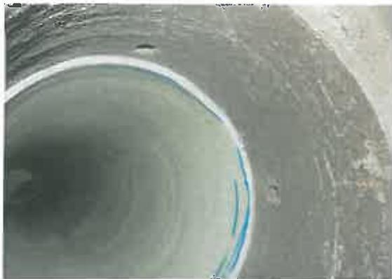
Bild 4: Bohrlöcher für das Aufbringen des Außenwassers
